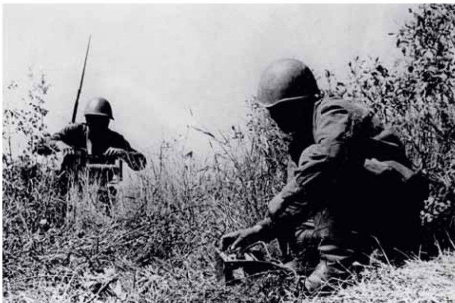
Прокладка телефонной линии. 1942 г.
